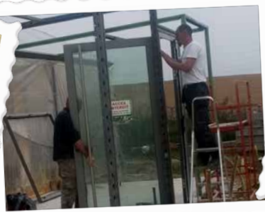
Les travaux prennent forme
